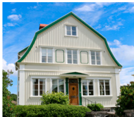
I en villa från 1928 på Olof Skötkonungsgatan i Örgryte, Göteborg, genomförde Celanders måleriarbete av fasad och fönster.
