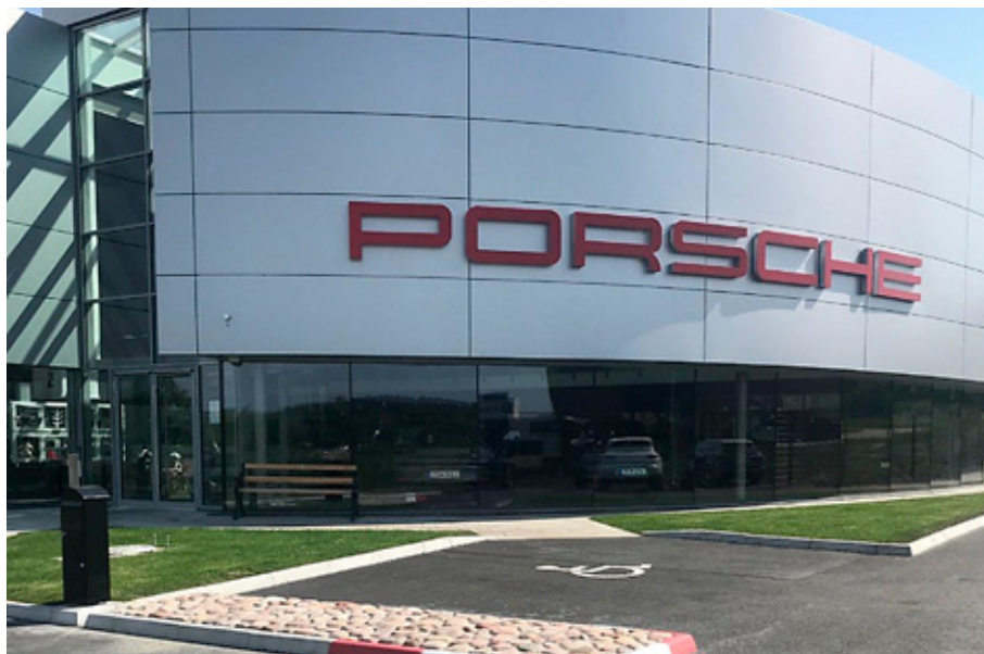
Hedlunds har utfört måleriarbeten på Porsche Center i Göteborg.
