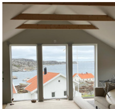
Här har Hedlunds målat takbjälkar samt åtgärdat sprickor runt fönstersmygar.
