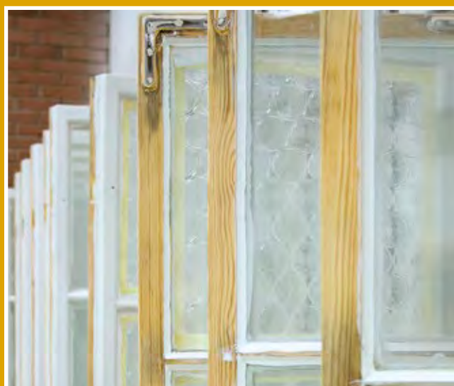
Fönsterrenoveringen gör P & A på uppdrag av Björsons Måleri i Katrineholm. Båda företagen tillhör företagsgruppen Nordisk Yta.
