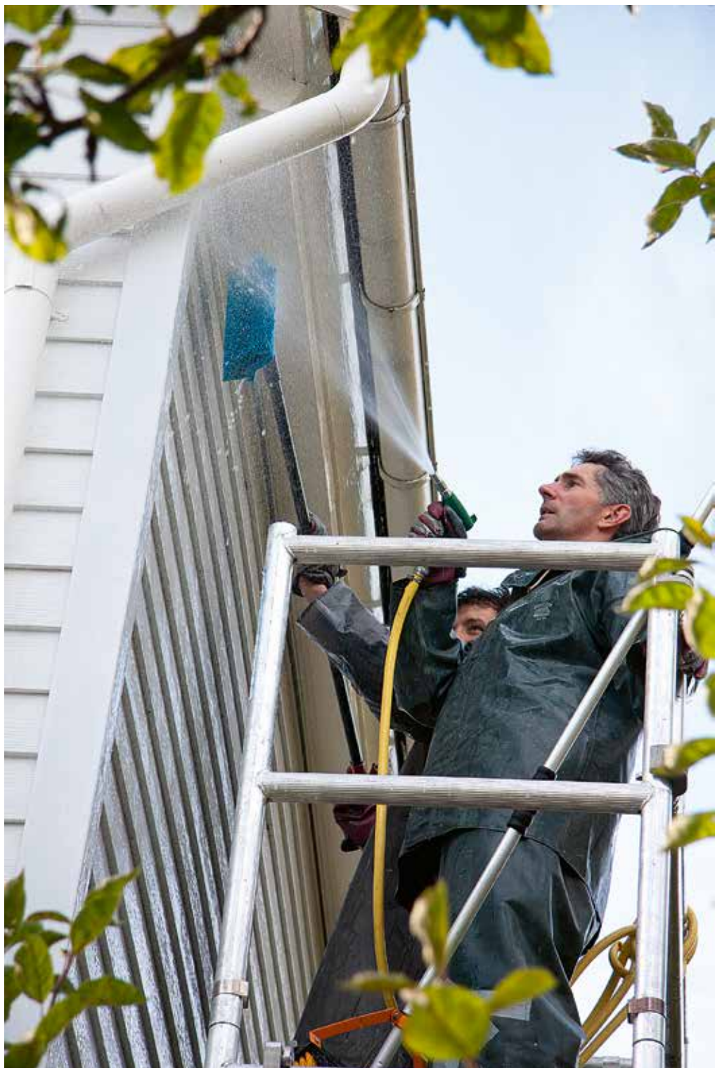
Rengöring av fasad före ommålning på Fasanvägen på Värmdö.
