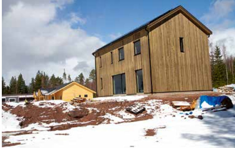
Slutet av april och det har vräkt ner snö så utvändiga måleriet fick vänta ...
