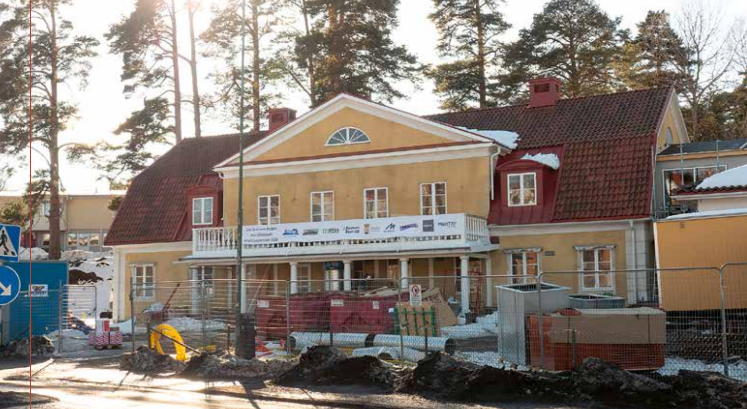
Kommunens gamla kulturskola totalrenoveras.
