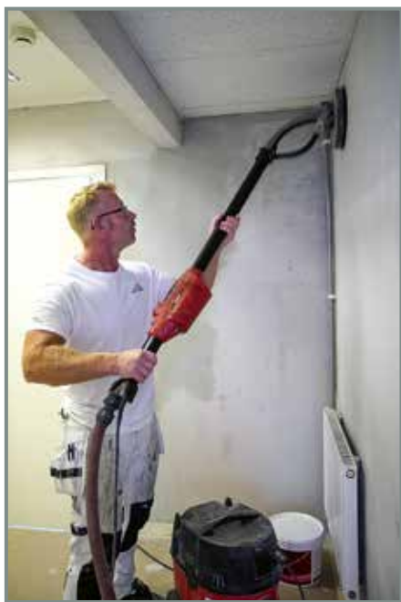
Thomas Sternhoff slipar väggar efter att ett utrymme har bredspacklats.
