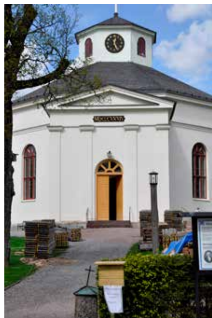
Silvbergs kyrka: Vacker kyrka vid sjön Grängen i Grängsammars bruk. Invändig och utvändig renovering.
