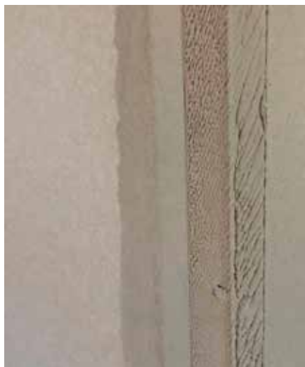
Remssläpp eftersom skivorna tandar.
