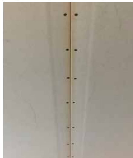
Cellulosagula kanter som blöder igenom målningsbehandlingarna.
