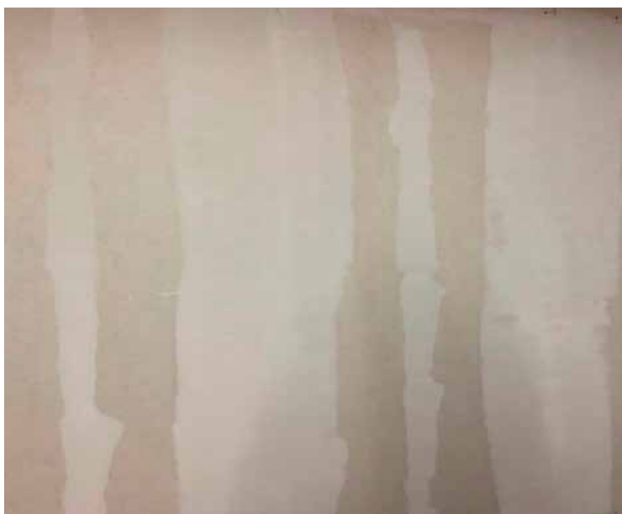
Målaren spacklar ibland 70-80 % av gipsskivorna fast de bara har betalt för 20 %.
