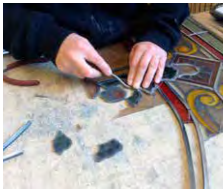
Isärplockning och rengöring. Vid restaureringen plockas varje fönsterdel noga isär och rengörs därefter. Är fönsterdelen svårt skadad byts den ut.
