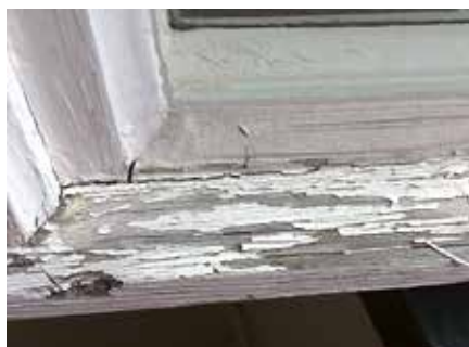
Sprucket och ruttet virke ska bytas ut. 110 till 130 µm färg kan inte täcka sprickor i träet som är millimetrar breda. I bilden till höger har gråträet gått ner 3 mm i träet. Antingen slipas ytan ner till rent trä eller byts träet ut.
