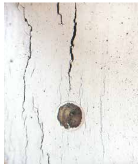
Sprucket och ruttet virke ska bytas ut. 110 till 130 µm färg kan inte täcka sprickor i träet som är millimetrar breda. I bilden till höger har gråträet gått ner 3 mm i träet. Antingen slipas ytan ner till rent trä eller byts träet ut.
