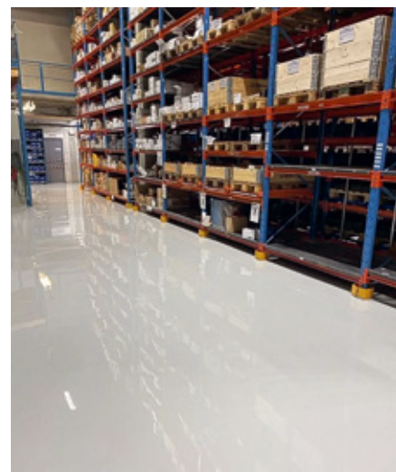
Ny SL epoxibeläggning i lagerutrymmen.
