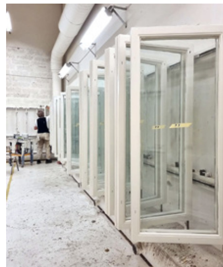
Fönsteravdelningen hos Holmlunds Måleri. Här renoverar de fönster från Västerbottens museum i Umeå.
