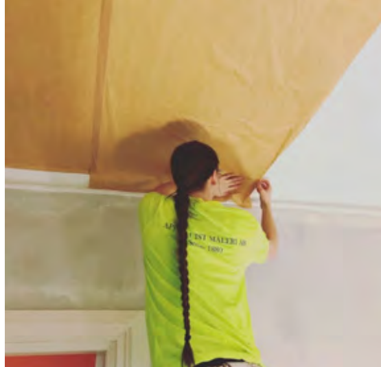
Rosalie komplettera ett trasigt vävtak med ny makulatur.
