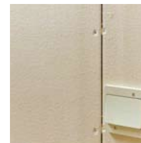
13:14 (Klass 3) Målad yta/gipsskiva. Vid nymålning utan underbehandling i t.ex. klädkammare/förråd.
